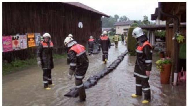
Im Ausserdorf wurde nach Überflutung eines Kellers sofort ein Behelfsdamm mittels Sandsäcken errichtet.
