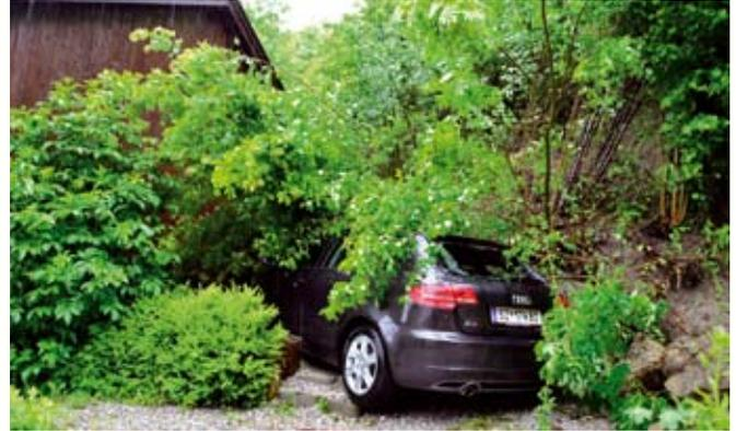
Durch einen Hangrutsch kippte hinter dem Haus „Tiefental“ die Hangschutzmauer um und verschüttete ein Auto.
