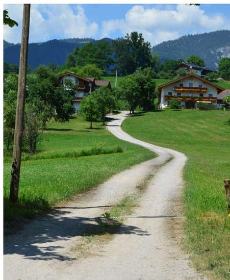
Hierzu wird die bestehende Zufahrtsstraße von der Hofstelle „Messnerbauer“ auf einer Länge von ca. 290 Laufmeter und einer Kronenbreite von 4,0 Meter ausgebaut, und davon eine Breite von 3,30 Metern asphaltiert.
